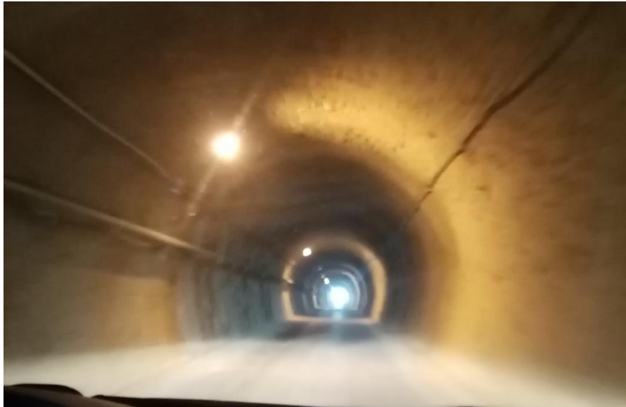
FIGURE 2. Adolfo Fattori, Tunnel , novembre 2020, Capo Miseno (Napoli).
